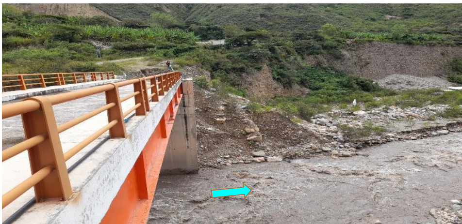
FIGURA N°01: TRAMO CRÍTICO EN EL RIO CHUSGON SECTOR EL NAYGUAPATA SE APRECIA AGUAS ABAJO LA NECESIDAD DE ENROCADO EN LA MARGEN IZQUIERDA
