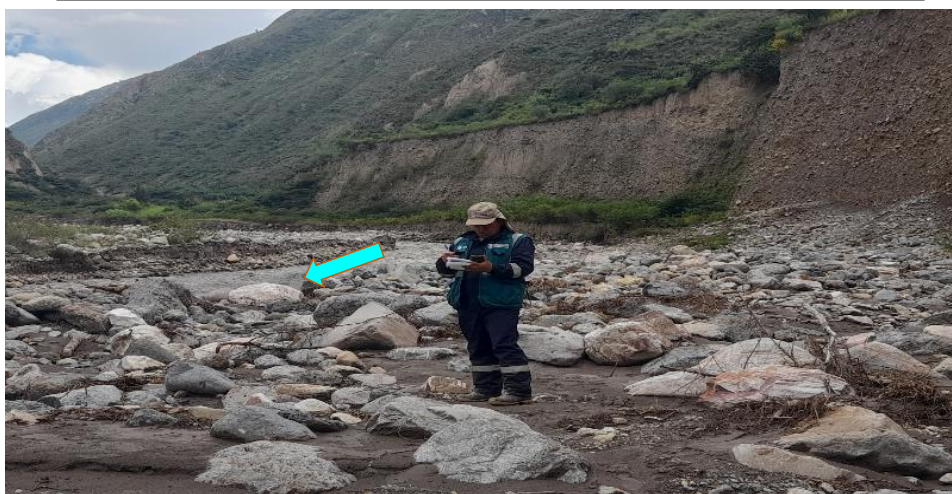
FIGURA N°02: SE VISUALIZA QUE REQUIERE DE MANTENIMIENTO Y PROTECCION ANTE LA EROSION DE LA MARGEN IZQUIERDA EN EL SECTOR NAYGUAPATA DEL RIO CHUSGON
